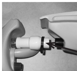
Fotografía 12 (Área en la que se coloca el tornillo).
